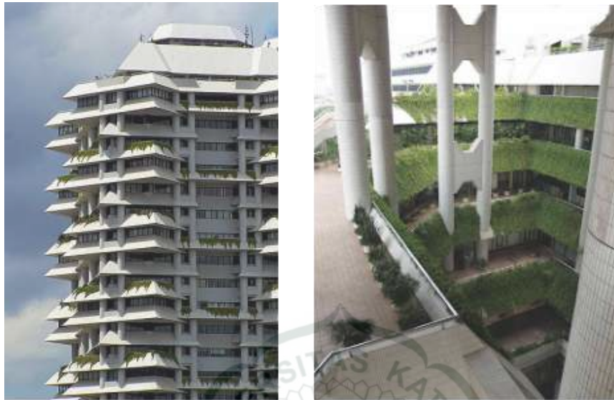
Gambar 1.2 Bentuk selubung bangunan (kiri); Atrium pada bagian podium (kanan)
