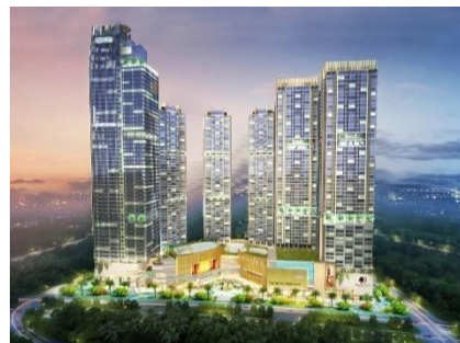
Gambar 1. 2 Superblok Menara Jakarta Sumber: Agung Sedayu Group
