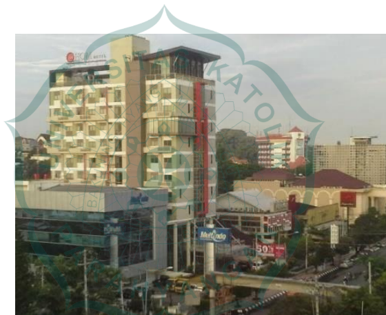
Gambar 1.4 Bangunan Hotel @HOM Semarang di Jalan Pandanaran (Sumber: www.google.com , diakses pada tanggal 24 Maret 2021)
