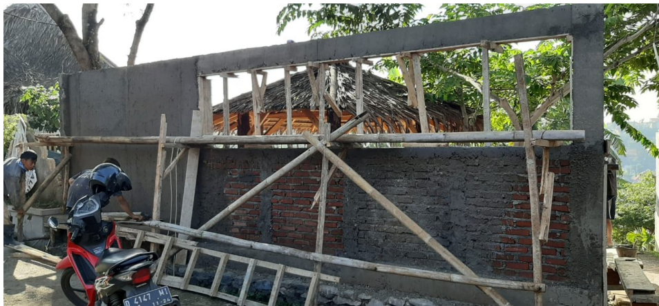
Gambar 1. 3 Proses Pembangunan dinding greenwall SD Arunika Waldorf
