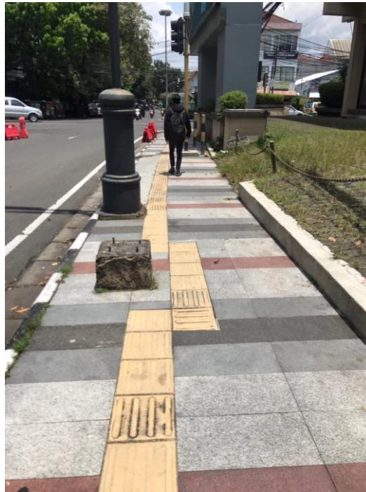
Gambar 5 : Susunan guiding block yang salah pada belokan
