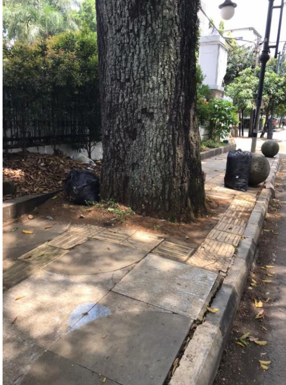
Gambar 3 : Kondisi guiding block pada trotoar di Kota Bandung
