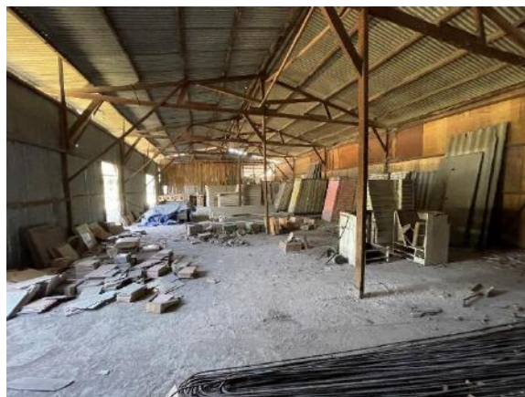
Gambar I.5 Lokasi Penyimpanan Kelima
