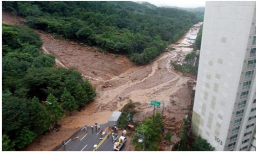
Gambar 1 2 Dampak Kerusakan di Umyeonsan (Lee, 2018)
