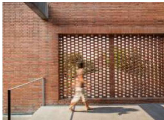
Gambar 1. 1Dinding Susunan Bata Berongga Sumber : www.google.com
