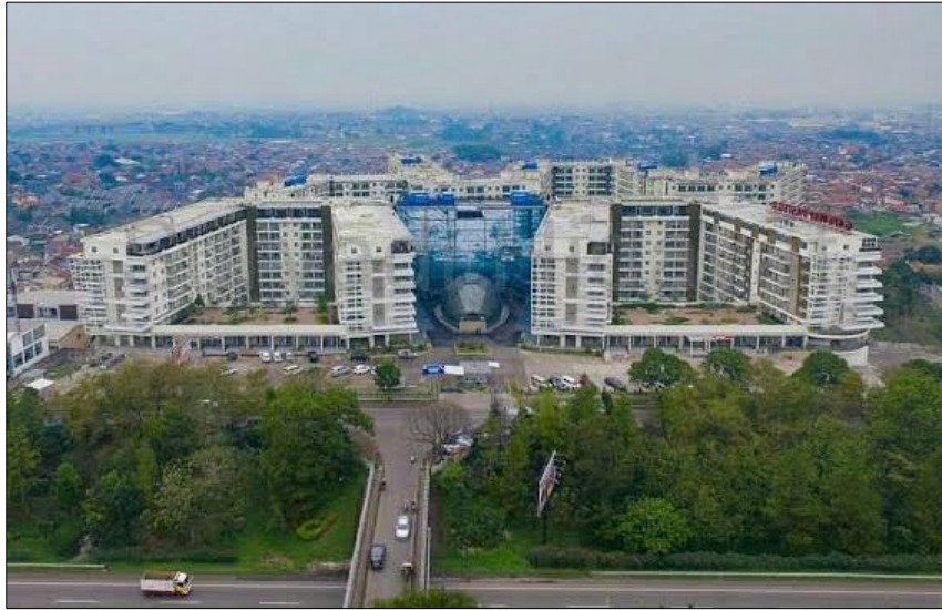
Gambar 1.1 Foto Bangunan Apartemen Gateway Pasteur Sumber: https://apartemengatewaypasteurbandung.com/
