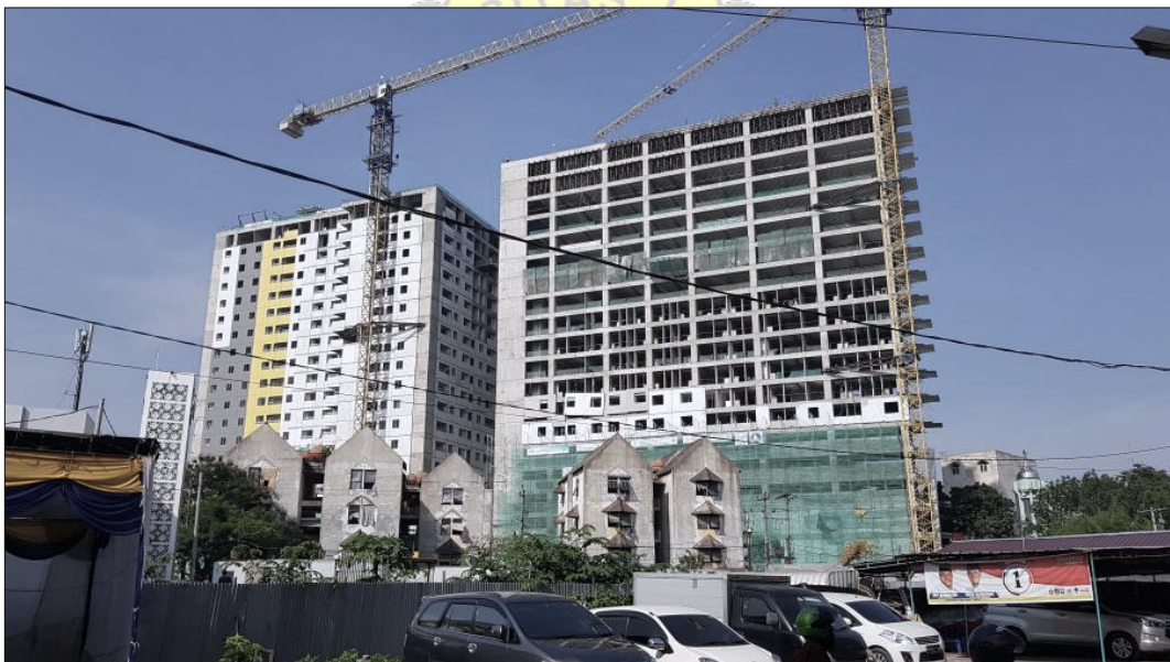
Gambar 1.1. Pembangunan Tower Santorini Apartemen Sentraland Medan (Sumber : http://rudychen.agenproperti.com/ )
