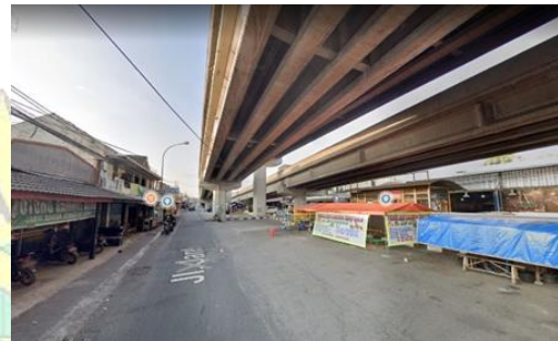
Gambar 1.14 Bawah flyover - batas selatan (Sumber : Google Streetview )
