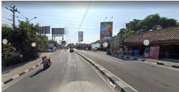
Gambar 1.27 Jalan Wates – batas timur (Sumber : Google Streetview )
