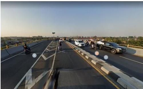
Gambar 1.15 Akses masuk-keluar flyover - batas selatan (Sumber : Google Streetview )
