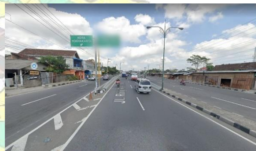
Gambar 1.8 Akses masuk flyover - batas timur (Sumber : Google Streetview )
