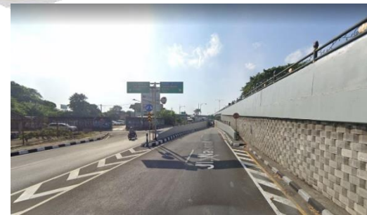
Gambar 1.10 Akses masuk underpass - batas barat (Sumber : Google Streetview )
