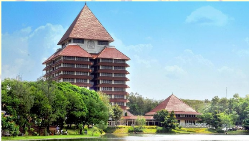
Gambar 1.1 Gedung Pusat Administrasi UI, Depok (sumber: google.com)
