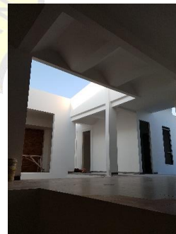
Area sirkulasi bangunan lantai 3
