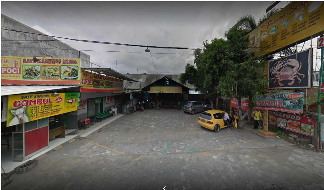
Gambar 1.3 Tampak Depan Rumah Makan D’Pawon Tegal
