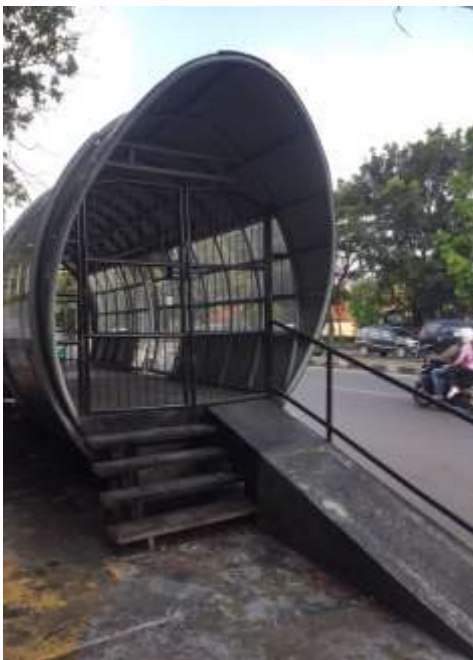
Gambar 1.4 Bentuk bangunan halte di Jalan BKR Bandung tidak aksesible
