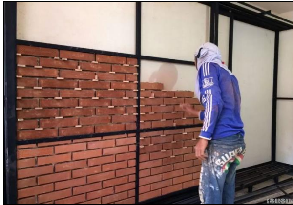
Gambar 1.4. Staging craftsmanship , Produk material cladding yang memberikan kesan ‘tradisional’ dari bata susun dan ‘ rustic ’ yang mulai diterima dan banyak digunakan dalam arsitektur.
