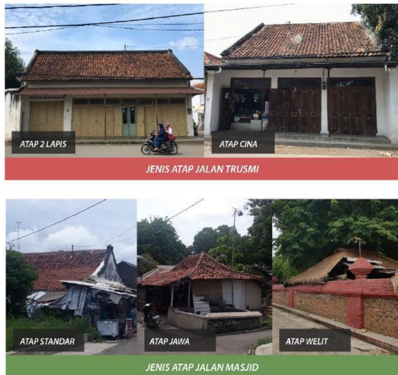
Gambar 5.3. Bentuk Atap Jalan Trusmi dan Jalan Masjid Sumber: Penulis
