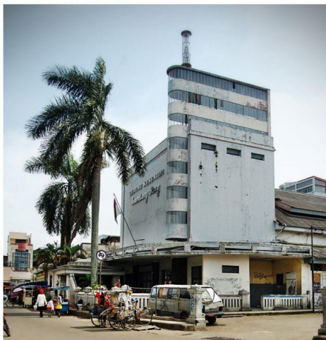
Gambar 1.1. Gedung Kesenian Rumentang Siang
