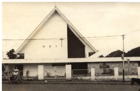
Gambar 1.1. Gedung GKI Veteran Sebelum Terjadi Kerusakan. (Sumber : Sekretariat GKI Veteran)
