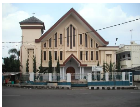
Gambar 1.5 Gedung GKI Veteran Setelah Melakukan Pembangunan Kembali.
