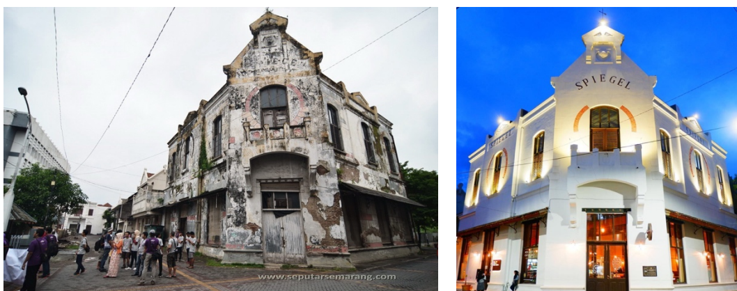
Gambar 1.1 Kondisi Gedung Spiegel Sebelum dan Sesudah Revitalisasi
